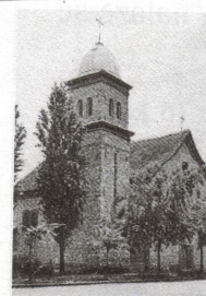
Modriča: 1889 Župna crkva SRUŠENA
