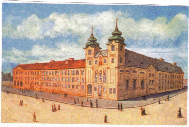
Sarajevo: Zavod sv. Josipa na Banjskom brijegu 1910-1911 OŠTEČEN
