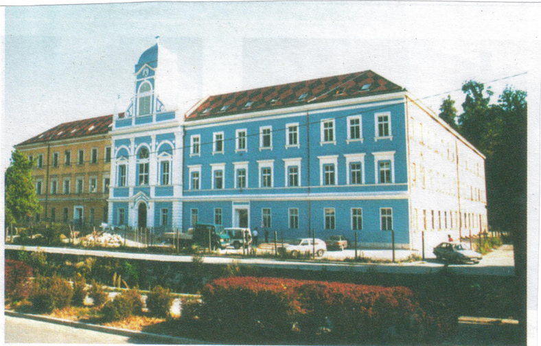
TRAVNIČKA GIMNAZIJA 1882-1888 OŠTEČENA
