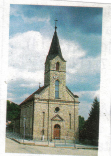
Podkraj: 1914 Župna crkva OŠTEC'
