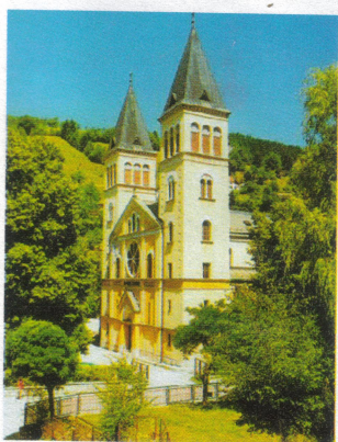
Vareš: 1906 Župna crkva OŠTEĆ.
