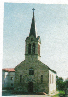
Brajkovići: Župna crkva 1897 OŠTEĆINA
