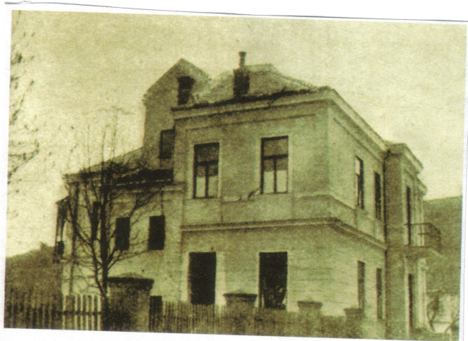
Dolac: Župna kuća 1902 OŠTEĆINA
