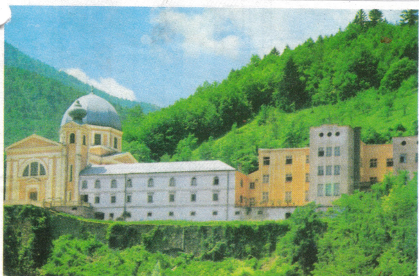
Fojnica: ošteć. Samostan i župna crkva 1863-1888
