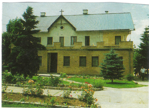
Stup/Sarajevo: Župna kuća 1891 - ošteć.
