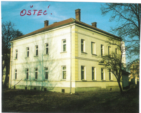
Brčko: Župna kuća 1925
