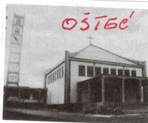
Potočani: Župna crkva 1974 OŠTEĆ!
