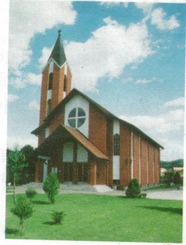
Lug/Brankovići: ošteć. Župna crkva 1987
