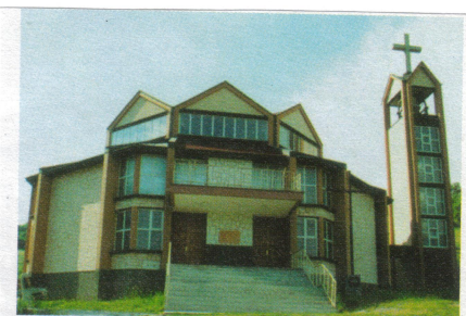
Skopaljska Gračanica: OŠTEC! Župna crkva 1969
