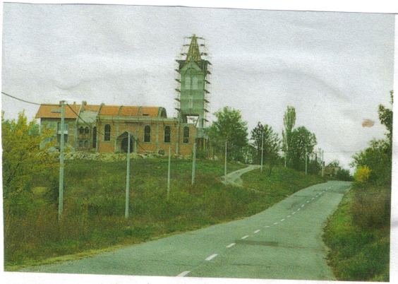
Bijelo Brdo: Pogled na novu župnu crkvu u izgradnji 2003
