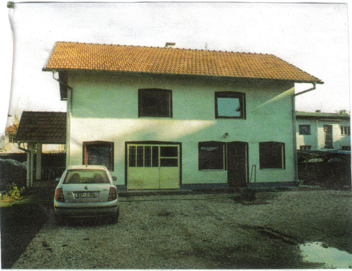
Modriča: Nova župna kuća 2001
