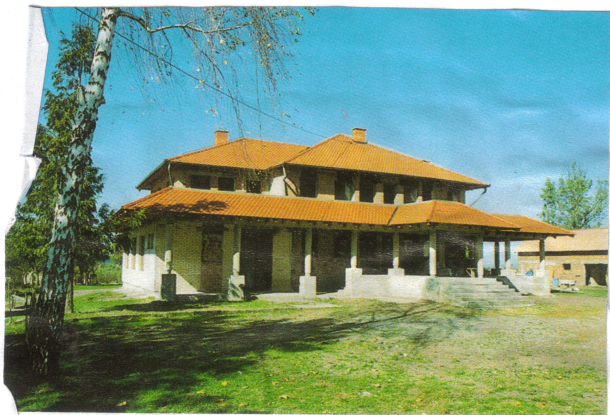
Žeravac: Nova župna kuća u izgradnji 2002
