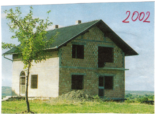
Kulina: Župna kuća u izgradnji
