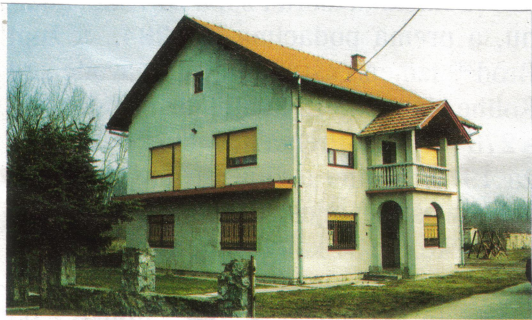
Gornja Močila/Sijekovac: Župna kuća ?
